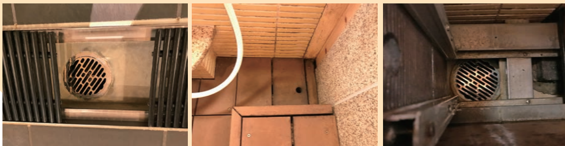
浴室内排水溝
