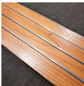
カーペットのスロープの始まりと終わりの見切りに木材を使って視認性を高めます。見切りに使う木材の床面には溝切り加工をして金属の目地棒を入れることで滑り止めや摩耗を防ぐだけではなく弱視の方に「ここに小さな段差や境界がある」という情報が伝わりやすくなります。
