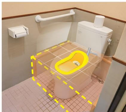
補助金を活用し、和式トイレの床をフラットにして洋式トイレへ改修した例。
