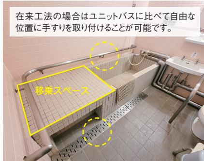
浴室入口の段差を解消する際、境界にグレーチング(排水溝)を設ければ、外への水漏れを防げます。
